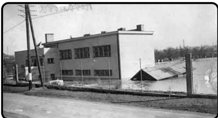
Nově postavená trojská Sokolovna byla zaplavena v roce 1940 (3300 m 3 /s).
