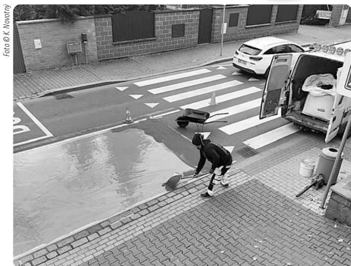
Úprava komunikace před MŠ a ÚMČ v ul. Trojská. Zlepšení brzdné dráhy vozidel z důvodu bezpečnosti. „Pokládka“ barevně zvýrazněného protismykového povrchu Rocbinda.
