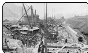
Stavba plavební komory na Vltavě u Klecan, 1897
